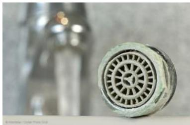
Wenn die Dichtung am Kopf des Wasserhahns ausgetauscht werden muss, also dort wo das Wasser austritt, ist es auch angebracht, das dort sitzende Sieb zu reinigen, da ein verschmutztes Sieb die Wasserqualität erheblich mindert.
